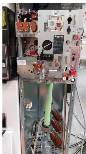
analyse des conditions de déclenchement sur court-circuit ou sur fuite à la terre. Remplacer des fusibles en HT n'est pas un jeu d'enfant....
